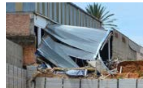
Fig 01. Agentes da Defesa Civil realizam vistoria em Taubaté (Fonte: O Vale).
